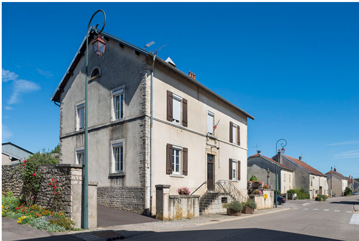
Mur pignon sud de l'édifice.
