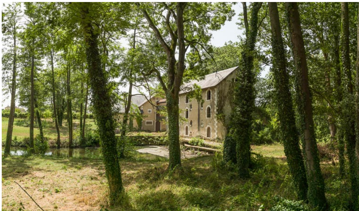
Vue d'ensemble du moulin.
