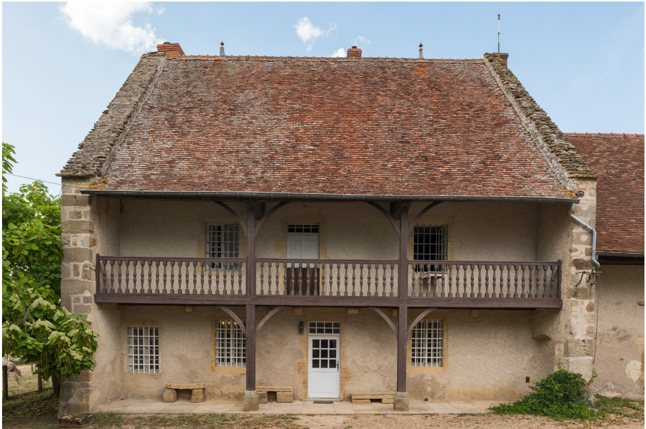
Vue de face de la maison. Façade antérieure.
