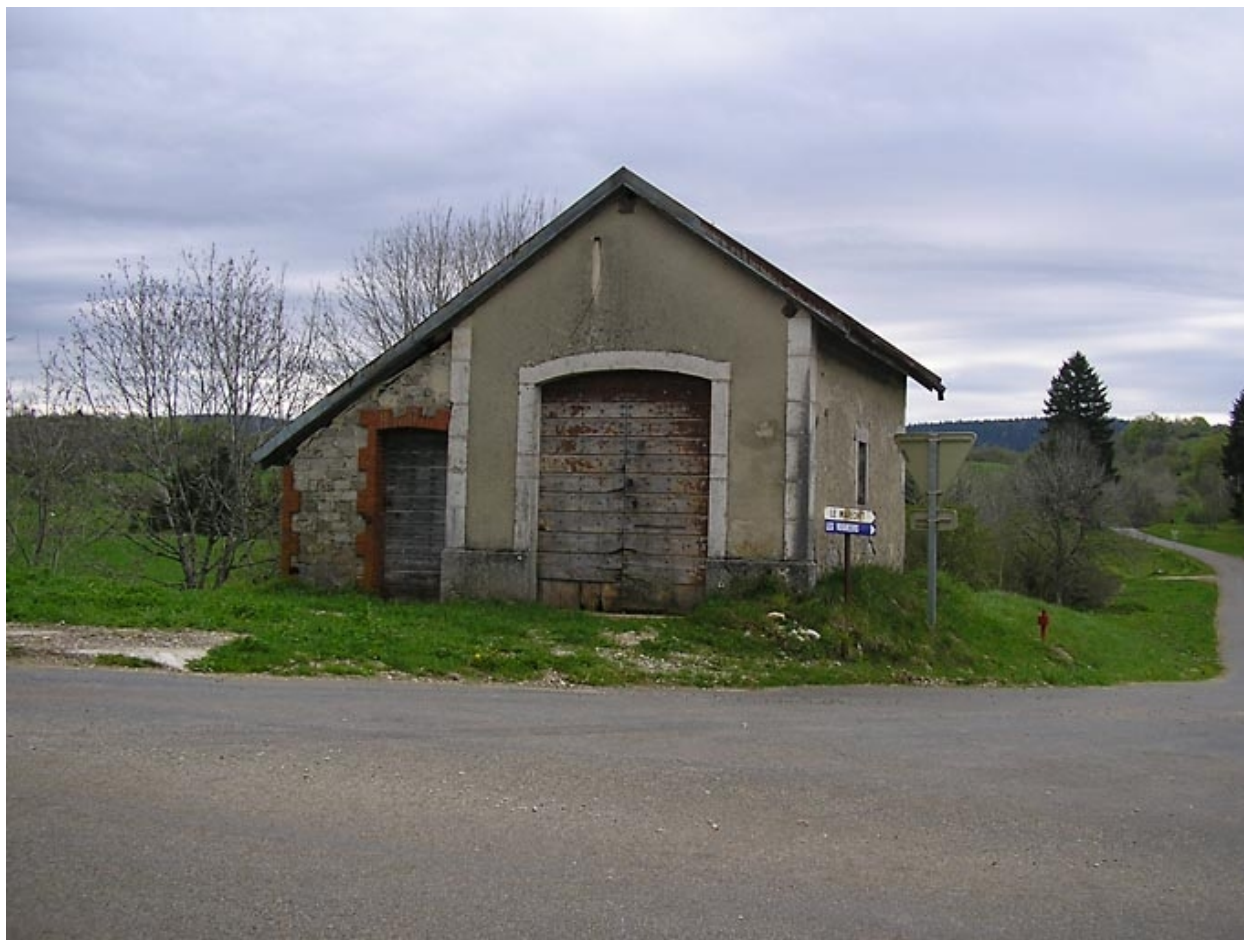
La remise de matériel d'incendie.
