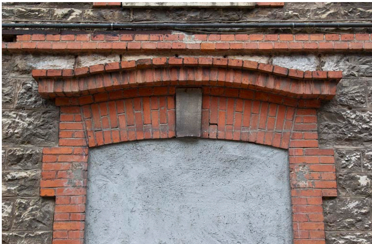
Détail d'une ouverture murée de la distillerie.
