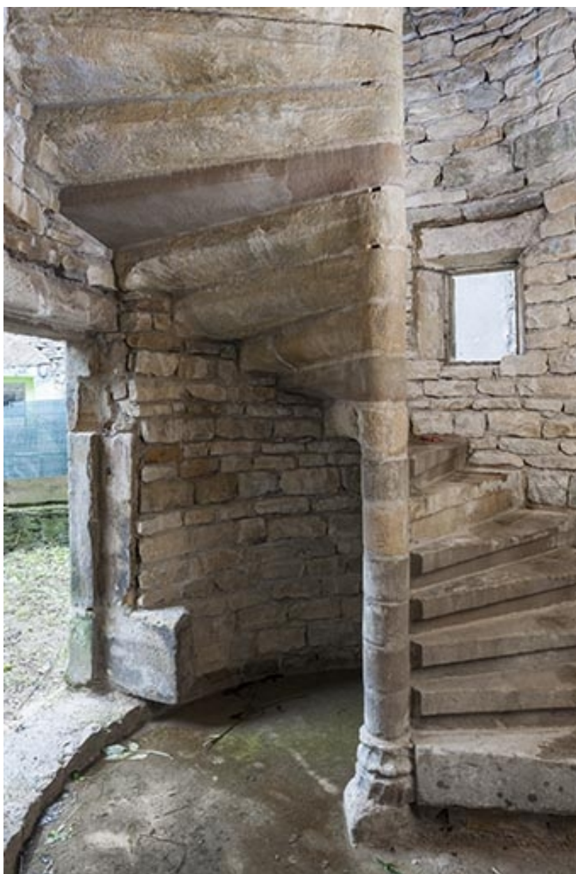
Intérieur de la tour : escalier en vis.
