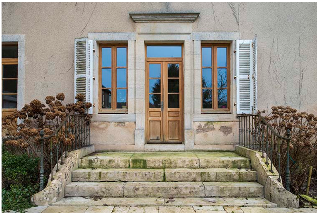
Détail de la façade postérieure.
