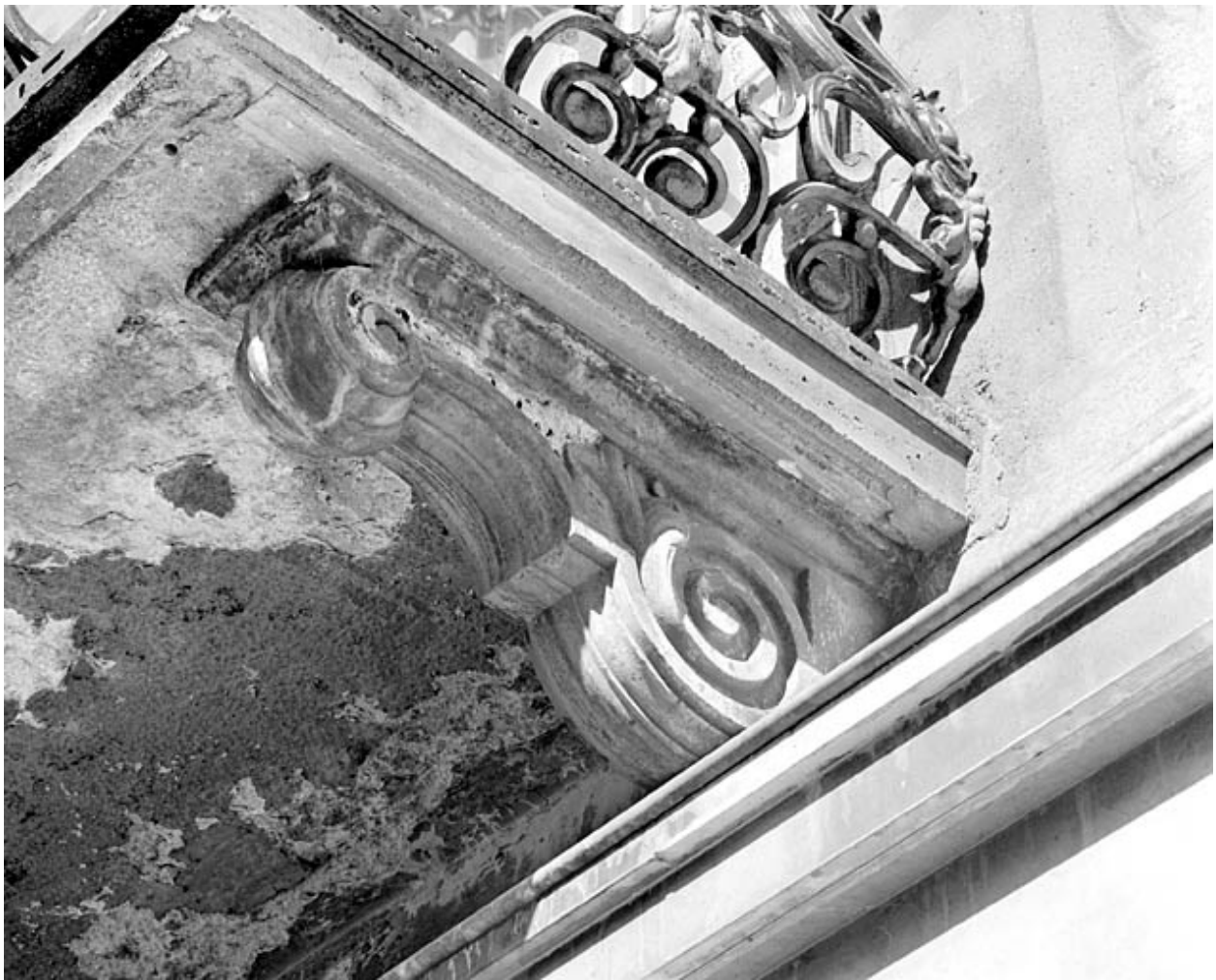
Balcon : détail d'une console.
