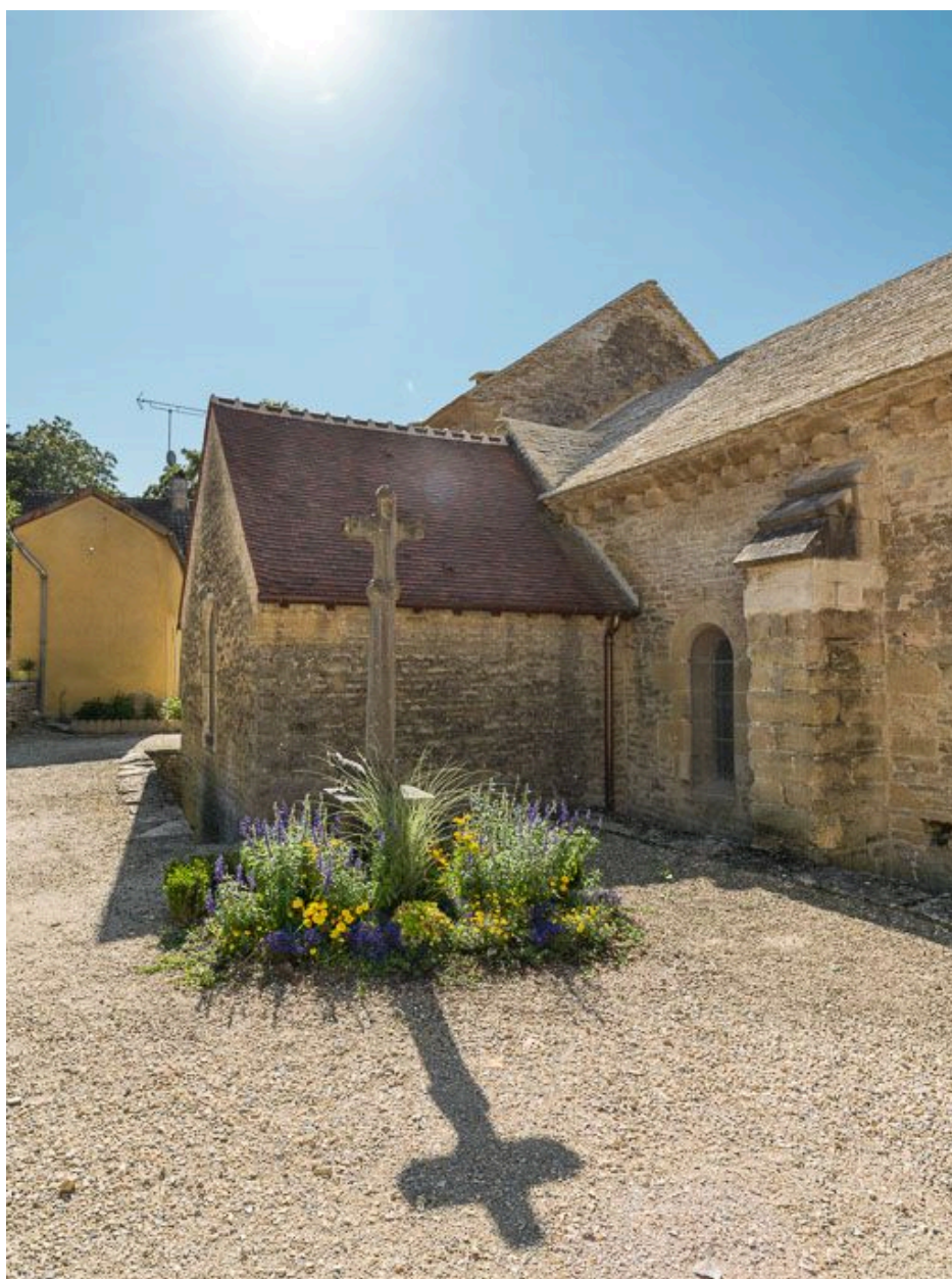
Croix monumentale et chapelle nord-est.
