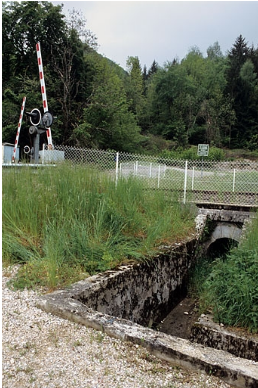
Tête aval (est) de l'aqueduc.
