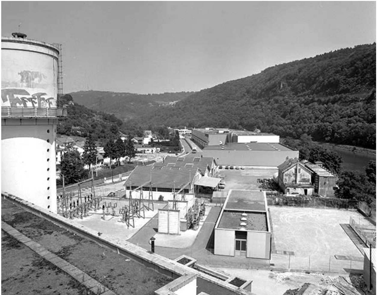
Poste de transformation (Y), atelier de la S.A. Spac Industrie et usine C.
