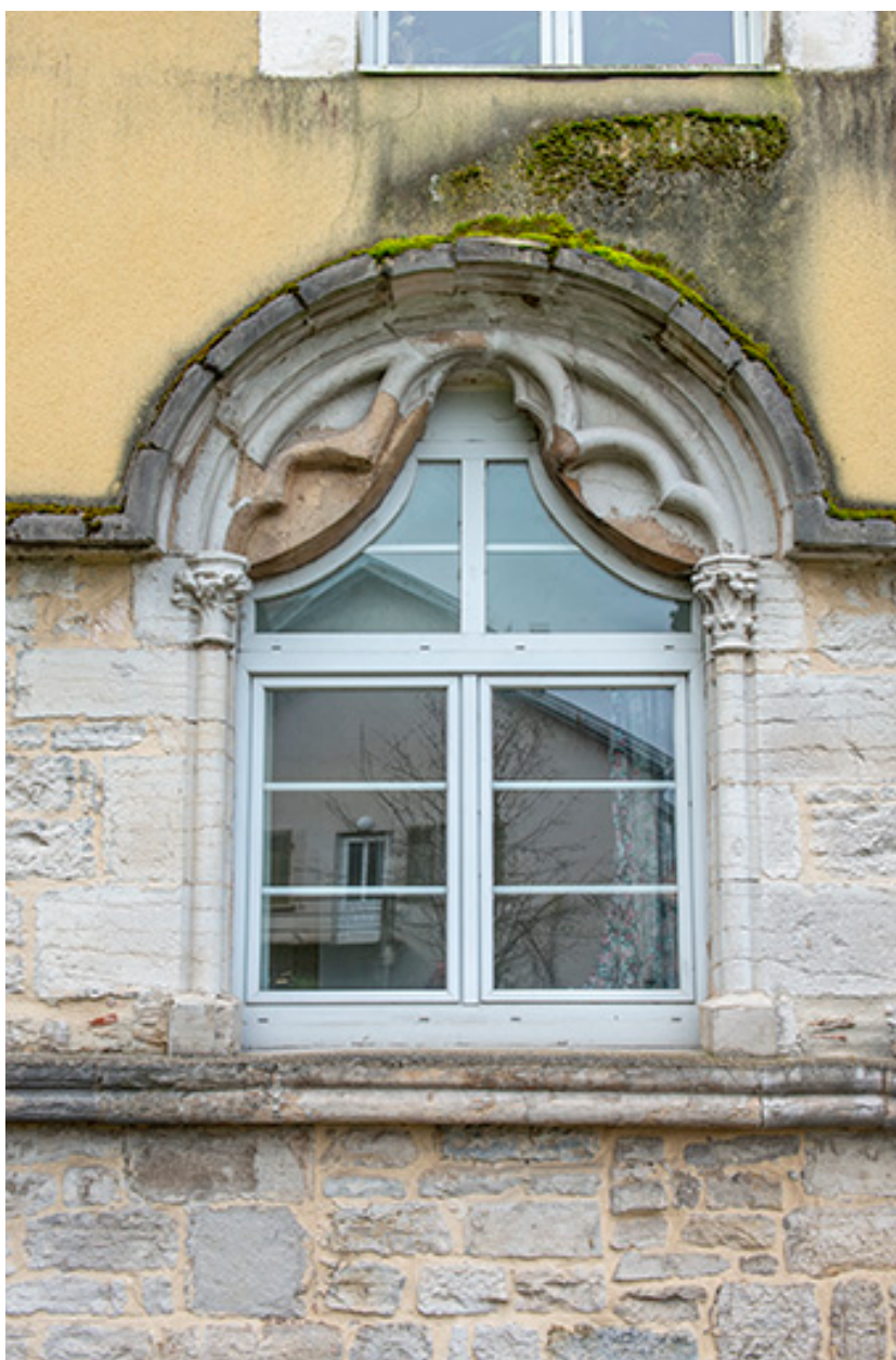
Façade nord. Détail de la fenêtre droite.
