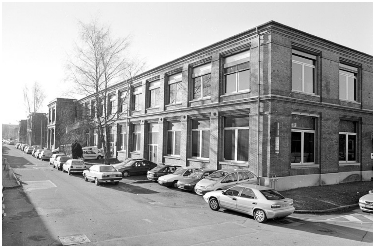
Atelier de finissage : façade est.
