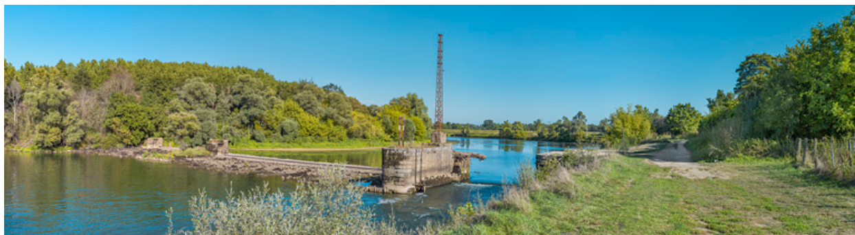
Vue d'ensemble du barrage en 2019.
