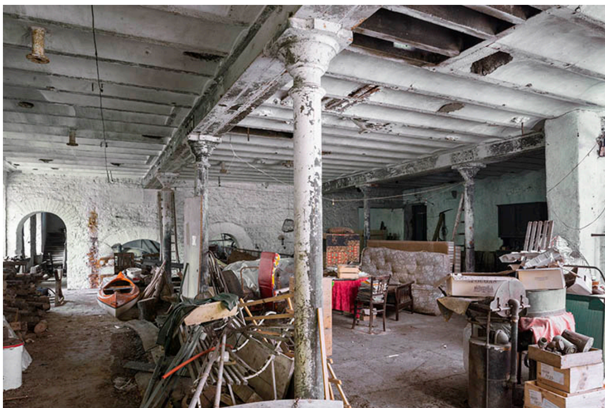
Atelier de fabrication. Vue du rez-de-chaussée.
