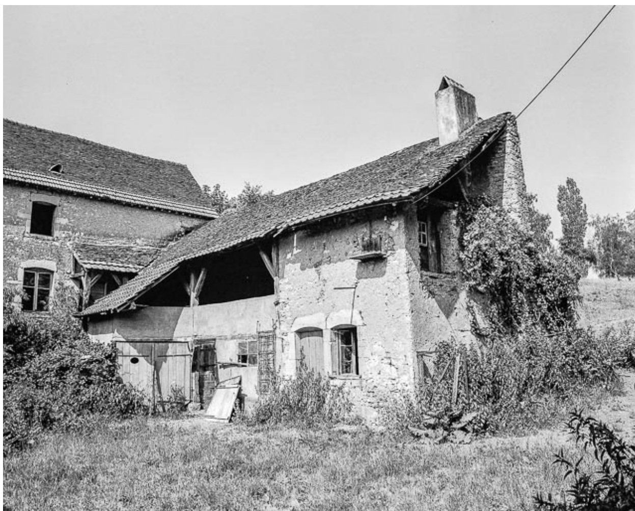
Façade antérieure et aile droite.
