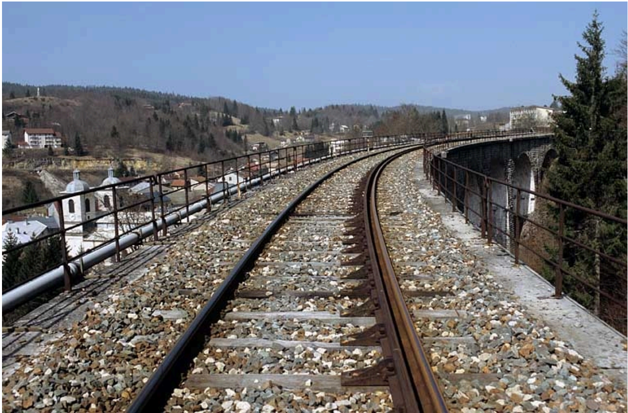
Vue d'ensemble du tablier et des garde-corps, depuis le côté La Cluse.
