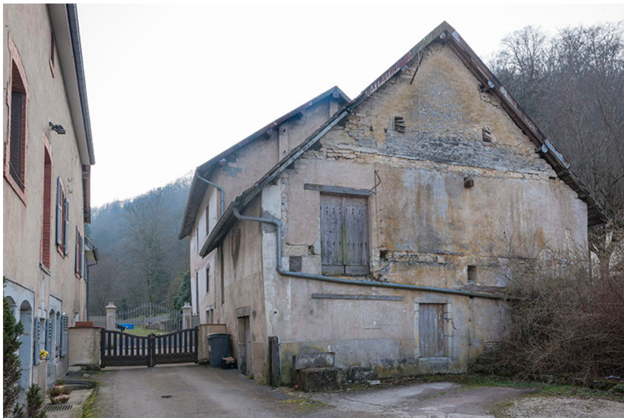
Façade est et pignon nord.
