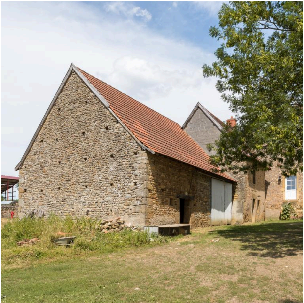
La façade antérieure et mur-pignon ouest : vue d'ensemble
