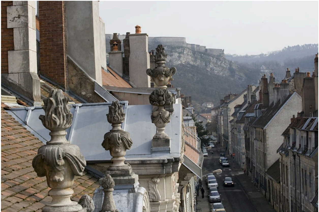
Détail des pots à feu décorant la façade sur rue.
