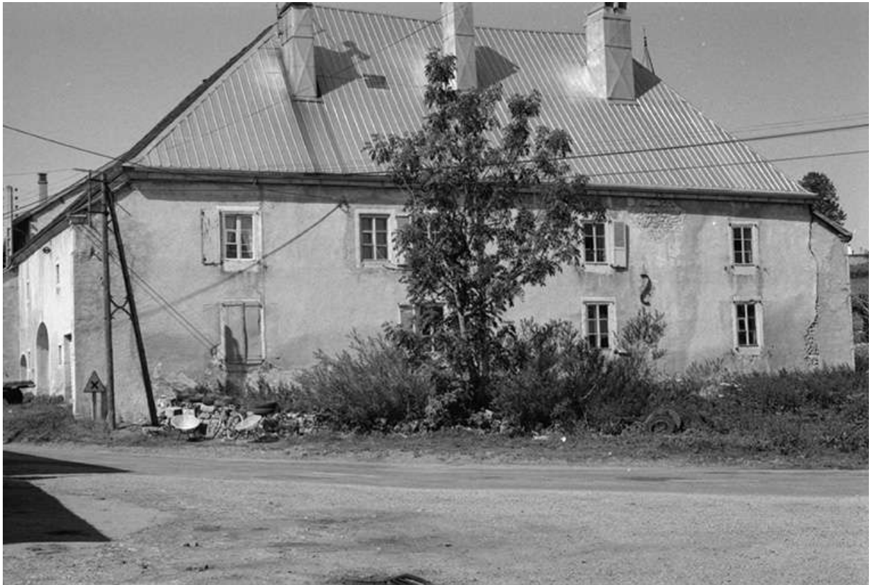
Façade latérale droite.
