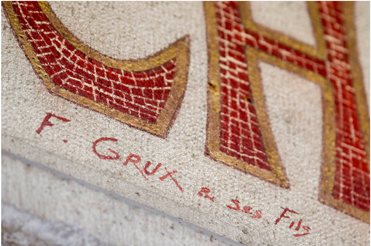
Façade antérieure : signature du peintre de l'enseigne (F. Grux).
