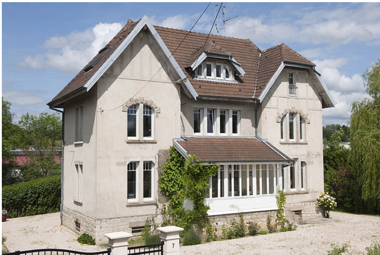
Logement (patronal ?) rue des Refroidières.
