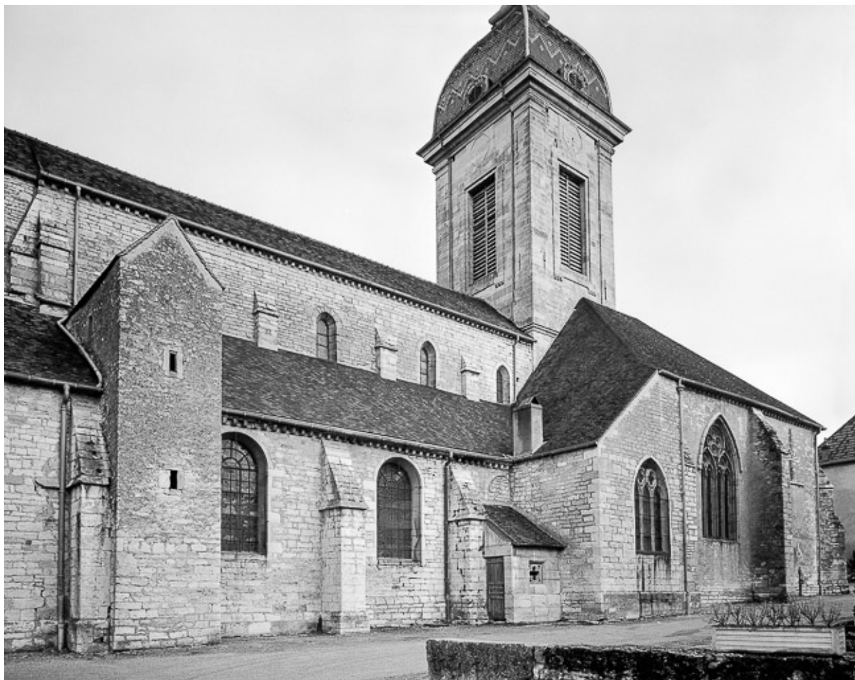
Extérieur : façade latérale sud.
