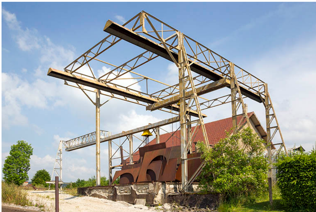
Site rue du Contremont : portique de manutention.
