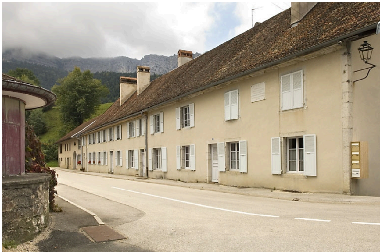
Bâtiment 62-64 rue des Forges, vu de trois quarts droite.
