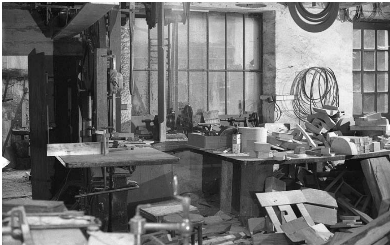
Vue partielle de l'atelier de menuiserie.
