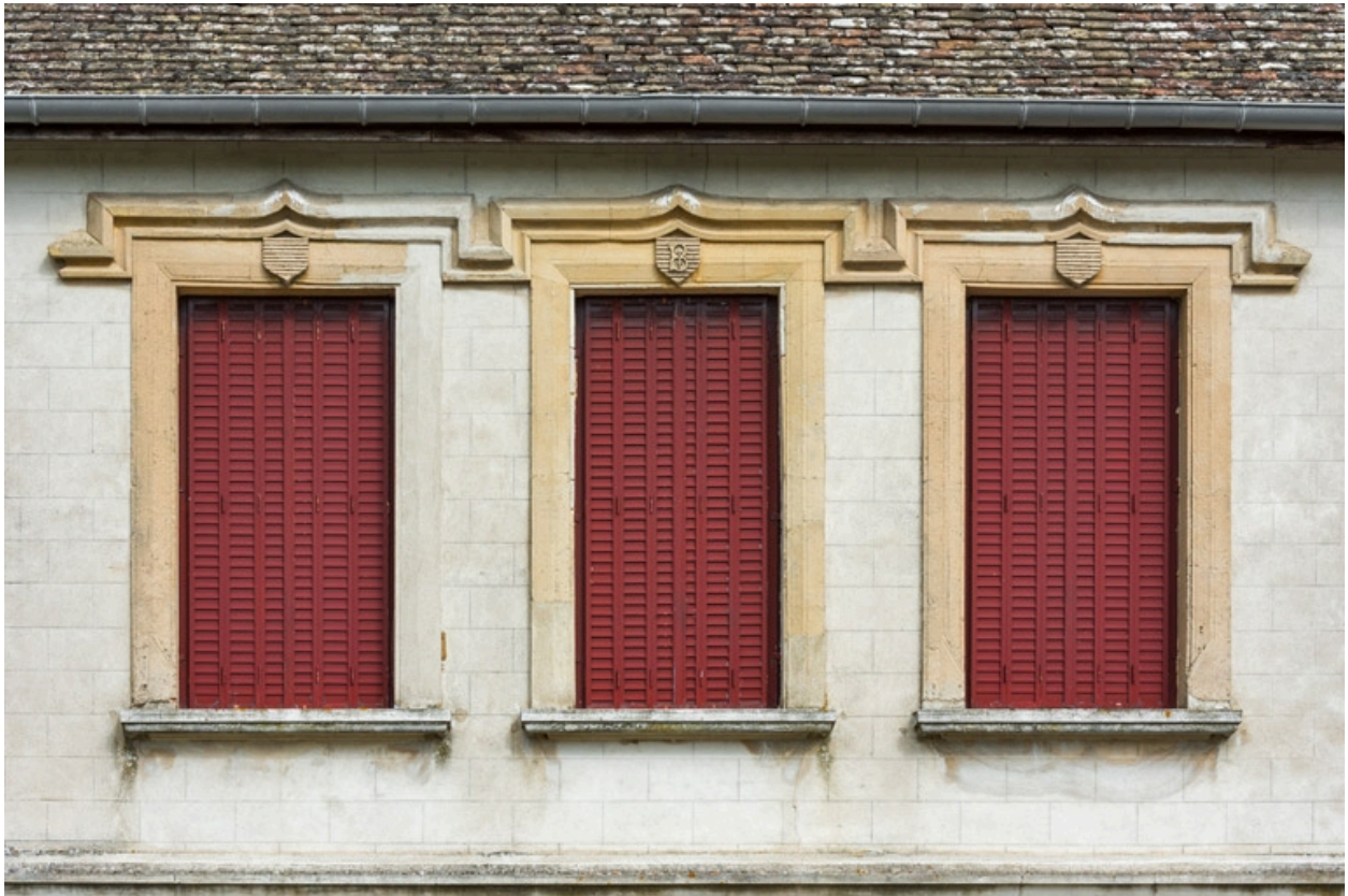
Elévation latérale gauche : baies de l'étage.
