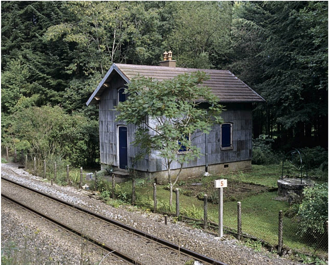
Façades antérieure et latérale droite.
