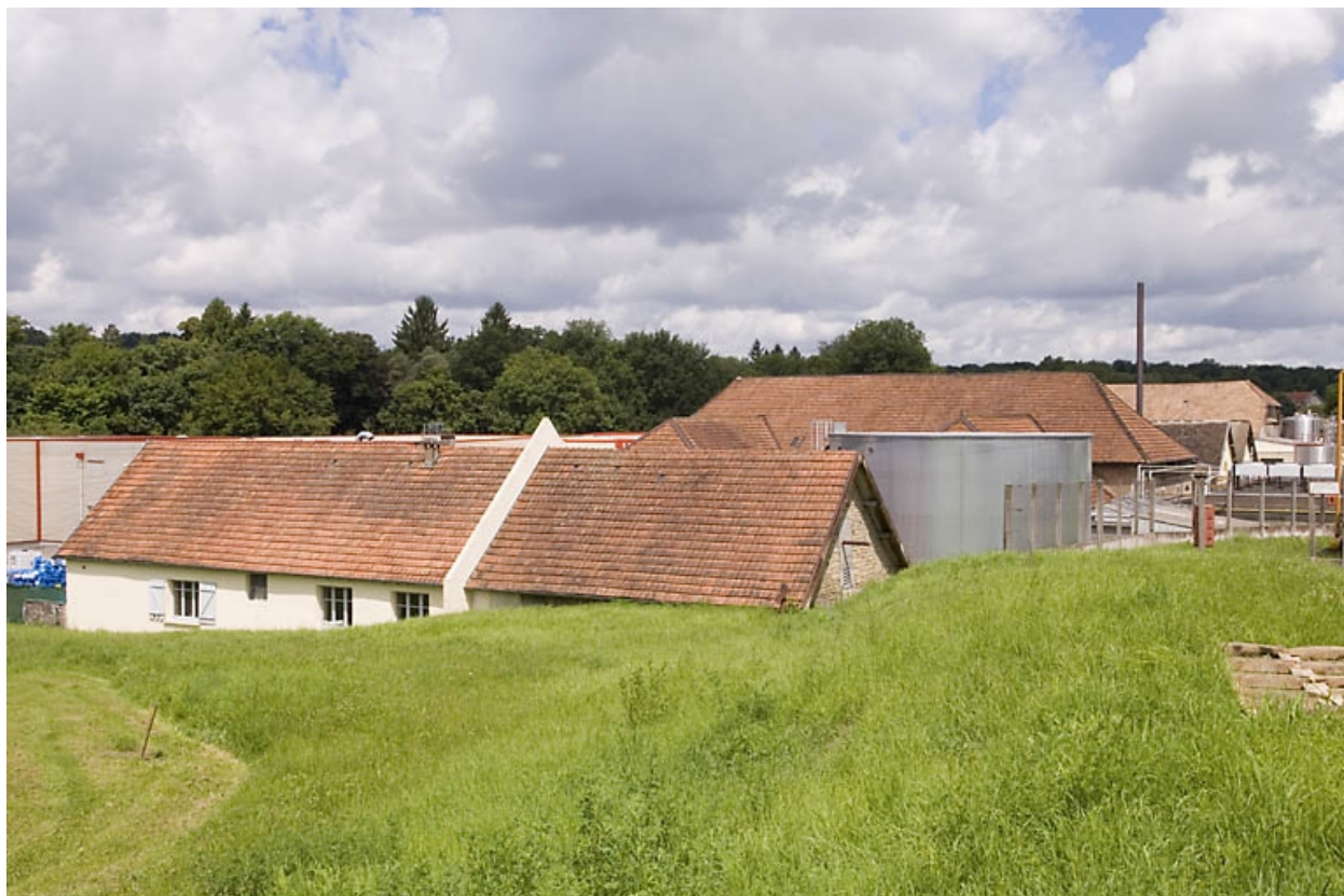
Vue sur les toitures depuis le sud-est.
