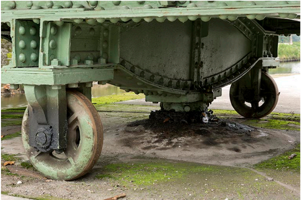
Détail du pivot sous le chevêtre.
