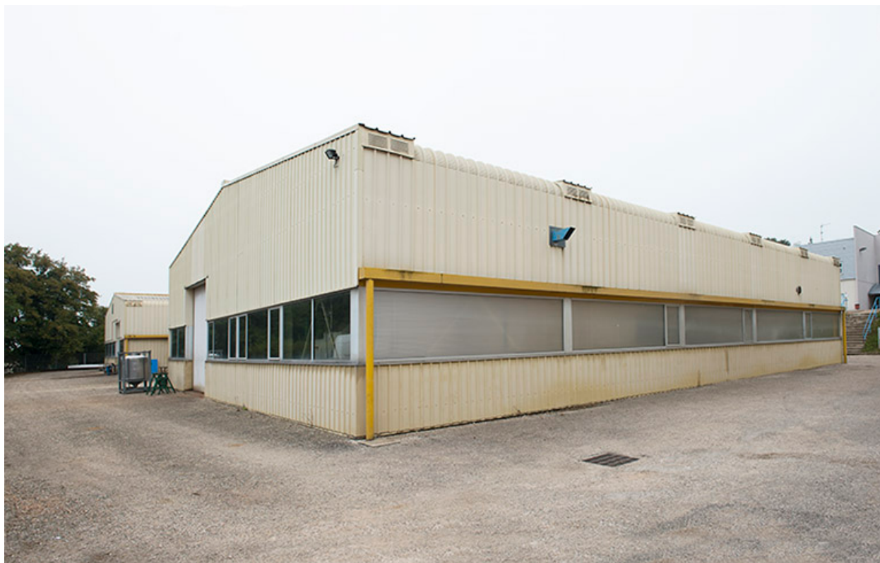
Atelier : vue trois-quart.
