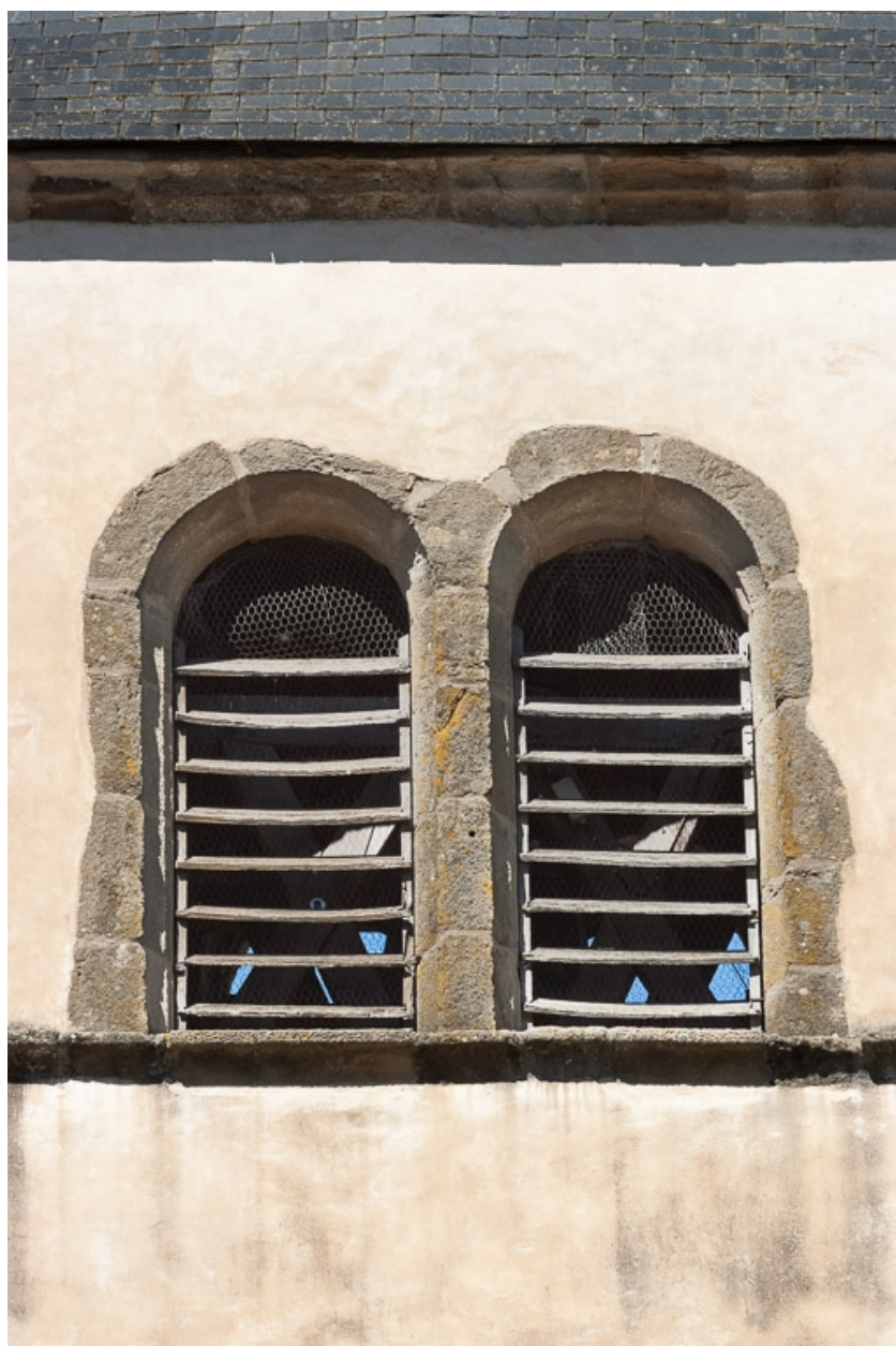
Clocher, détail de deux baies jumelées.
