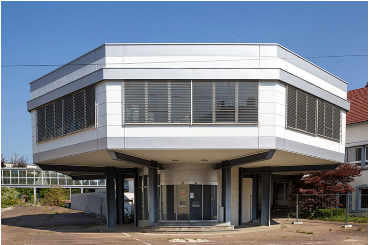
Usine : corps d'entrée.
