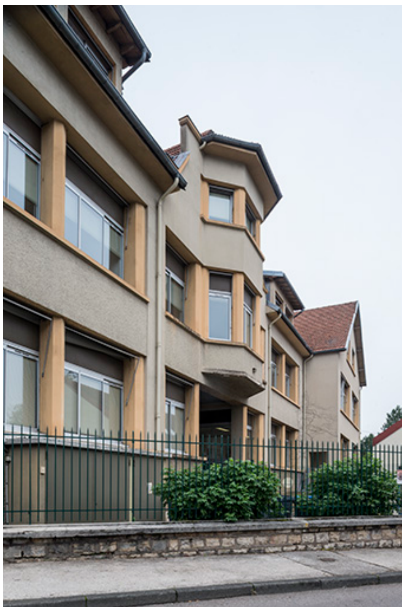
Façade antérieure vue de trois quarts gauche.
