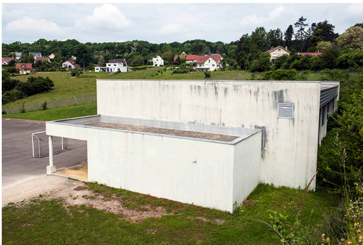
Angle sud-est du gymnase.
