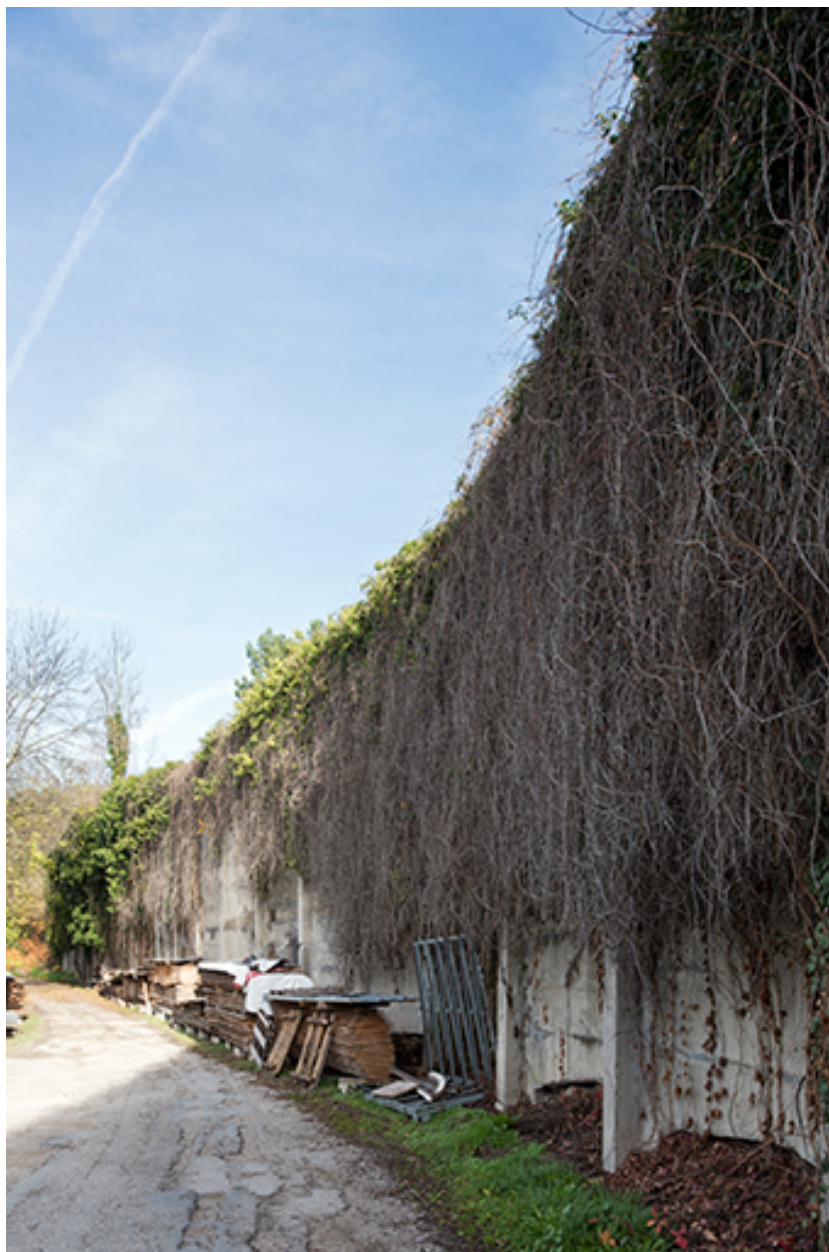
Mur de soutènement, depuis le sud.
