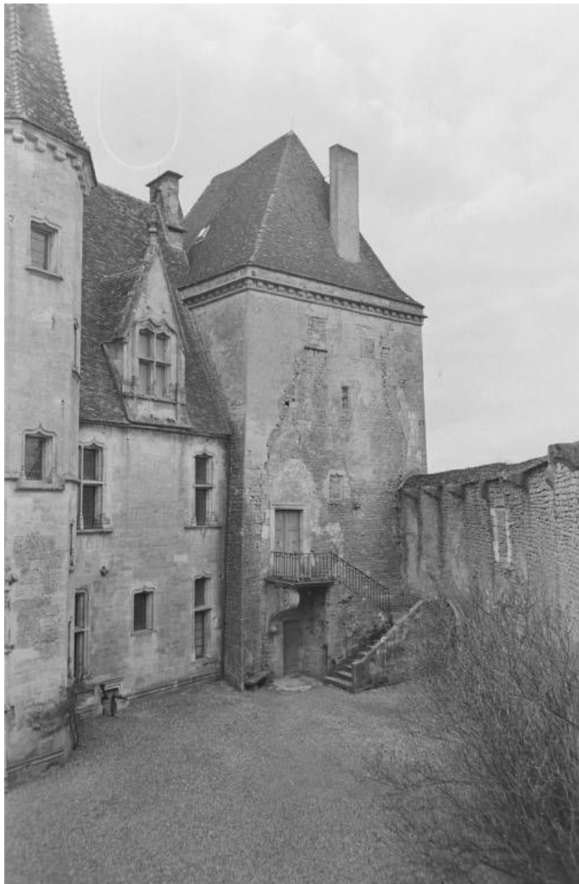
Corps de logis, vue partielle : la tour d'angle (photo prise en 1969).
