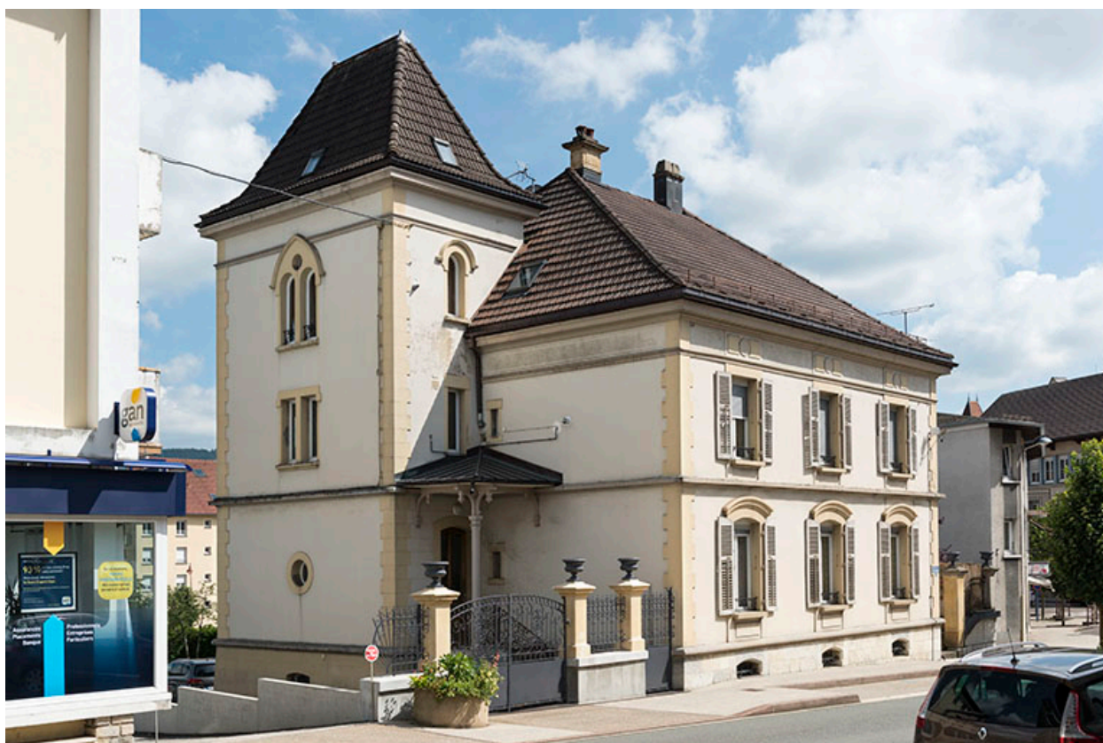
Façades antérieure et latérale gauche.
