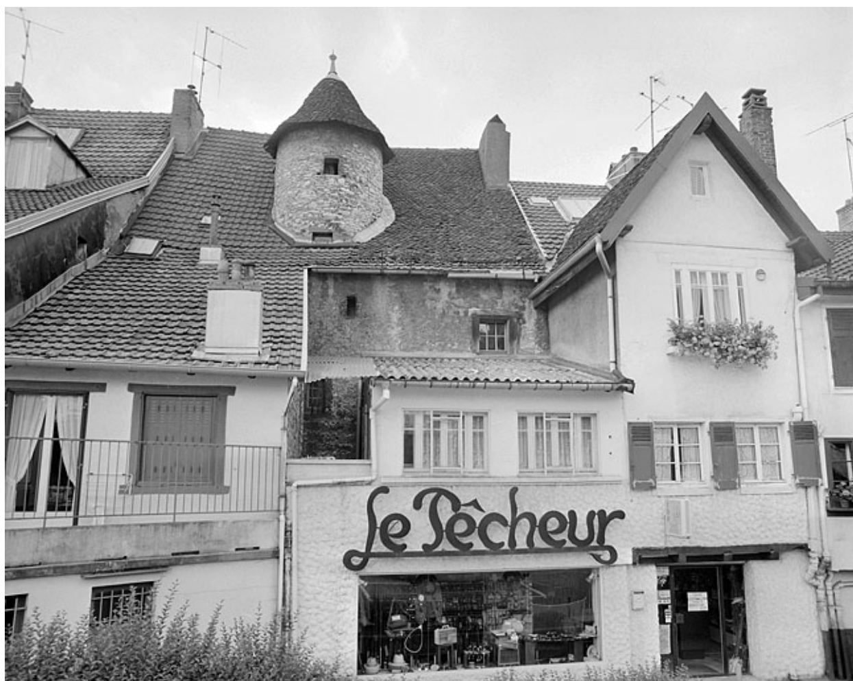
Façade sur la place de la Lizaine.
