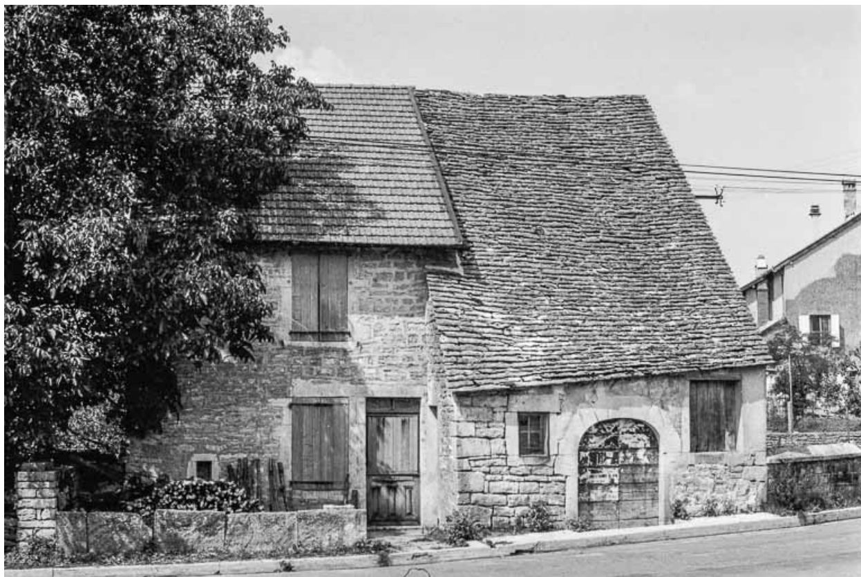
Ferme cadastrée 1951 E1 65 : façade antérieure.
