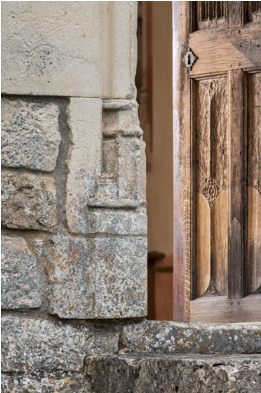
Piédroit, détail de la partie inférieure, gauche.
