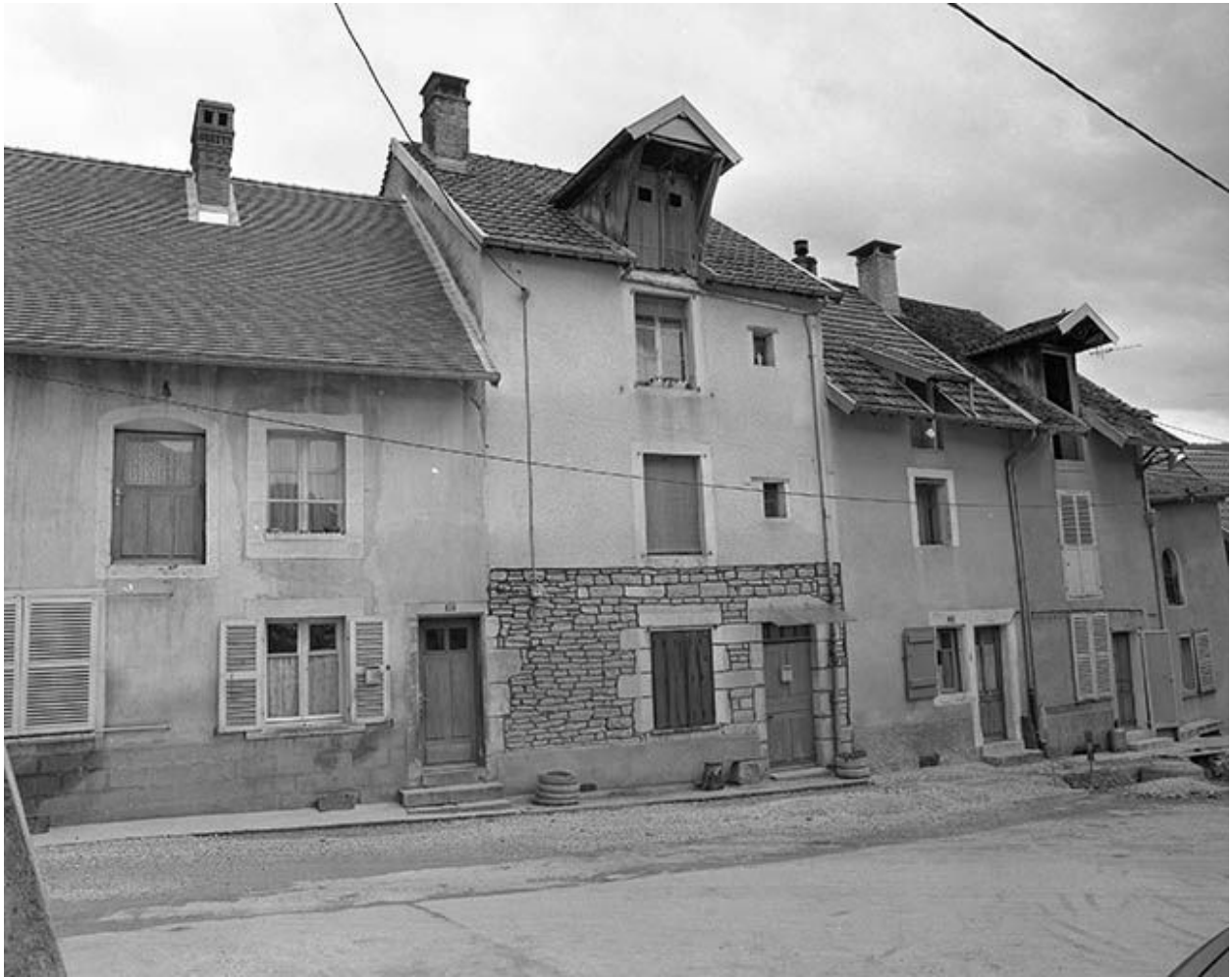
Maisons 6 à 12 rue des Martinets : vue générale.
