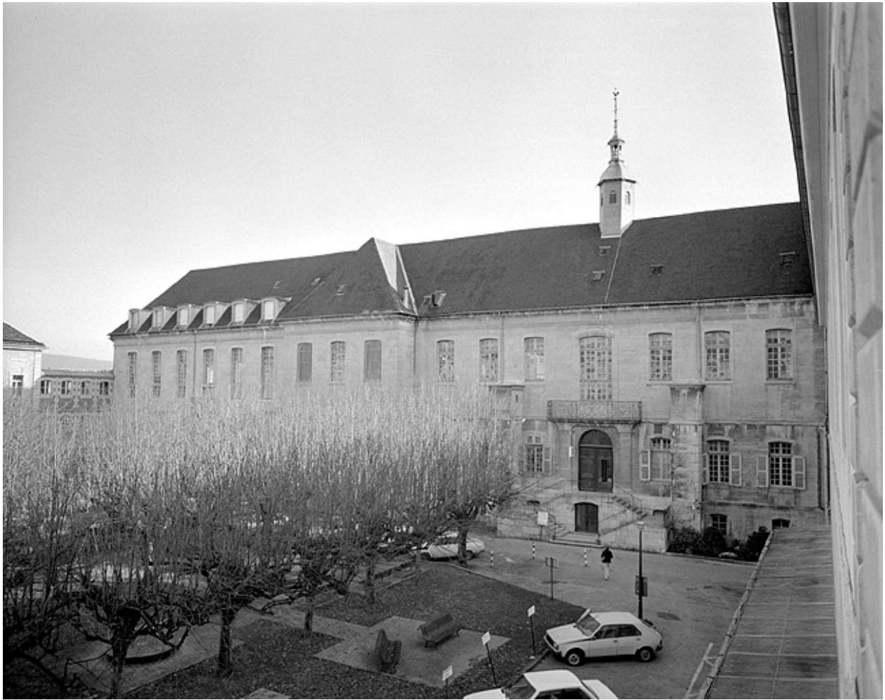
Façade postérieure, vue partielle.
