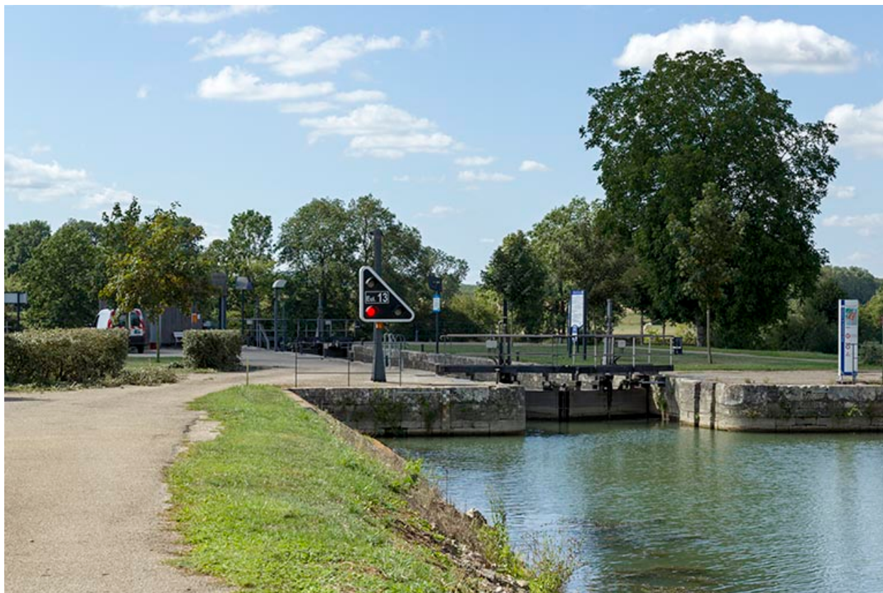
Entrée amont de l'écluse.
