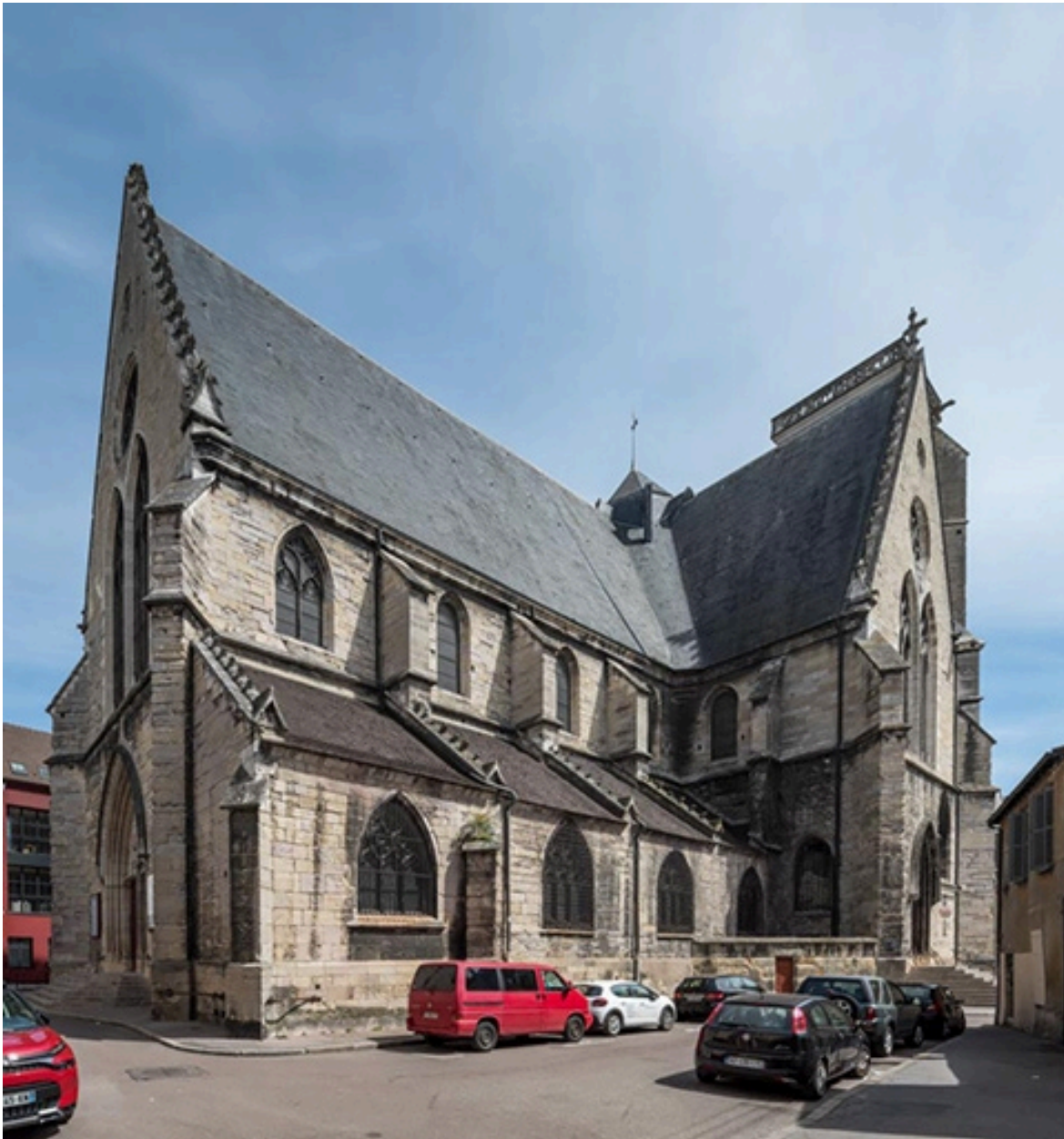
Façade sud, de trois quarts gauche.
