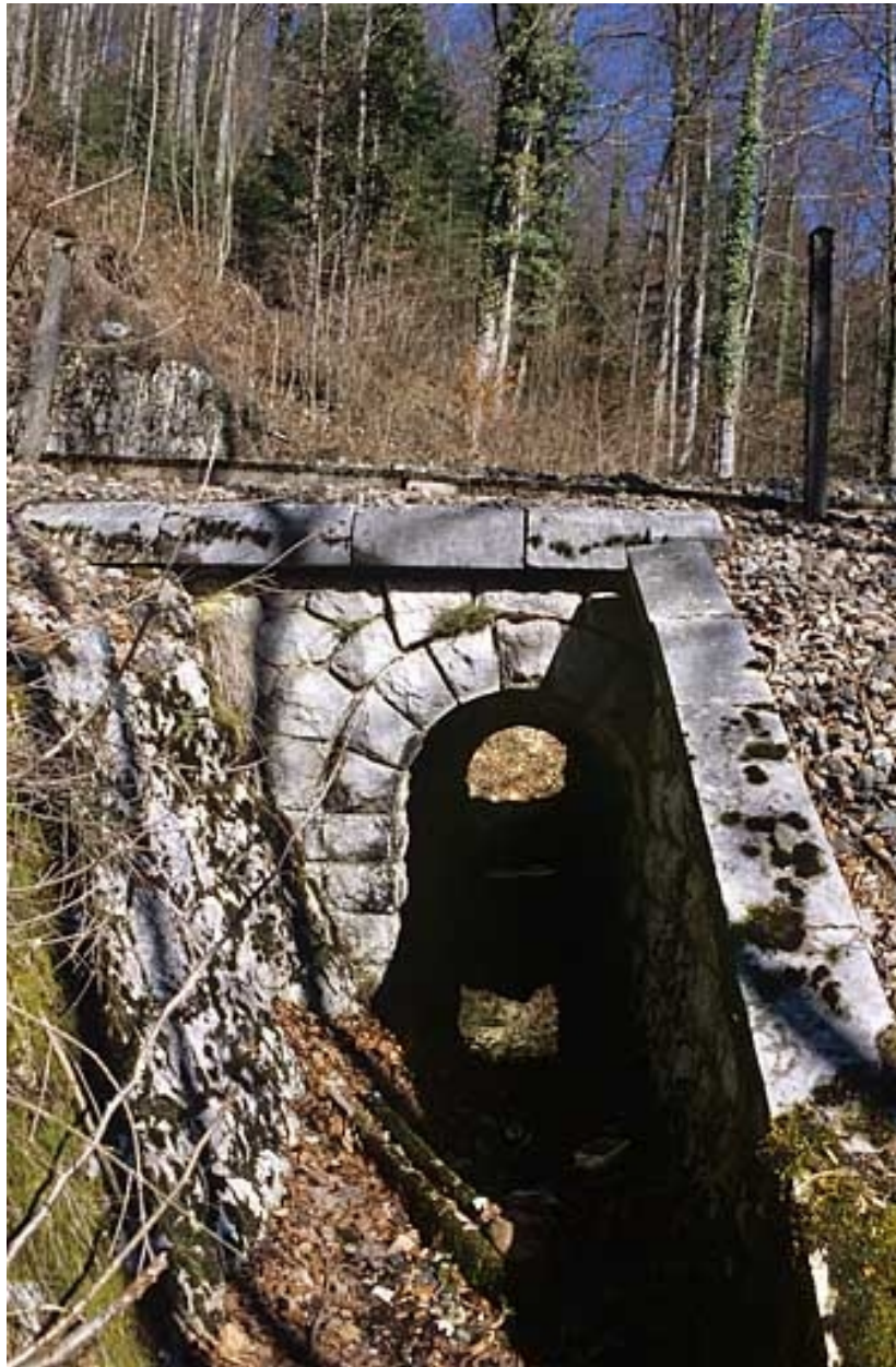
Vue d'ensemble, depuis l'aval (sud).
