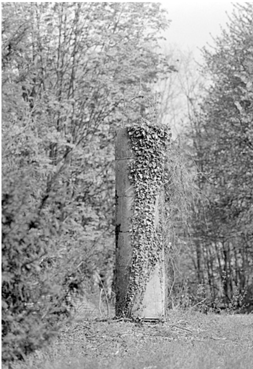
Pilier nord de la mire nord.
