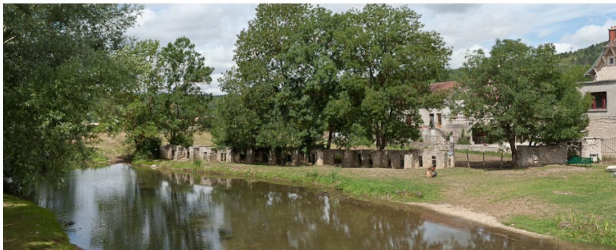
Vue du mur dit "évacuateur de crue".
