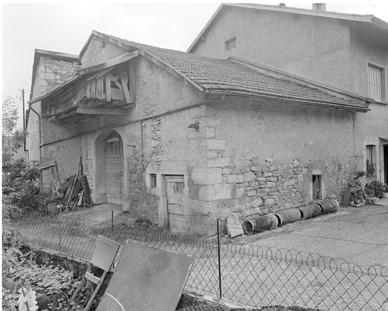
Face latérale et façade postérieure.
